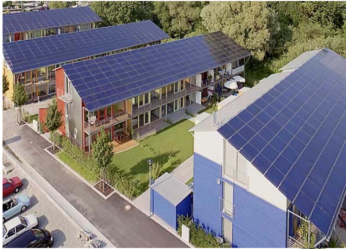
Source : Rolf Disch PlusEnergieHaus
